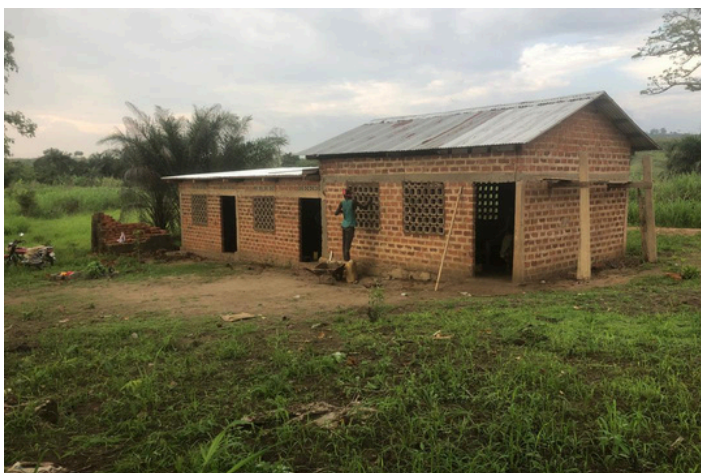
Schule in Lovo - Fertigstellung der Fenster 2026
